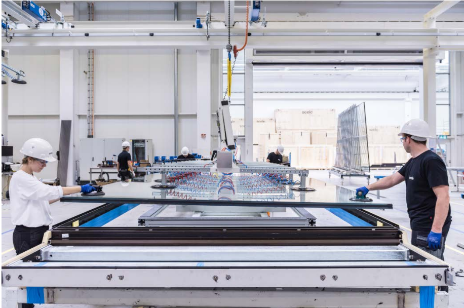
Die einzelnen SCF-Elemente für Principal Place werden bei seele millimetergenau vormontiert. ©seele/René Müller
