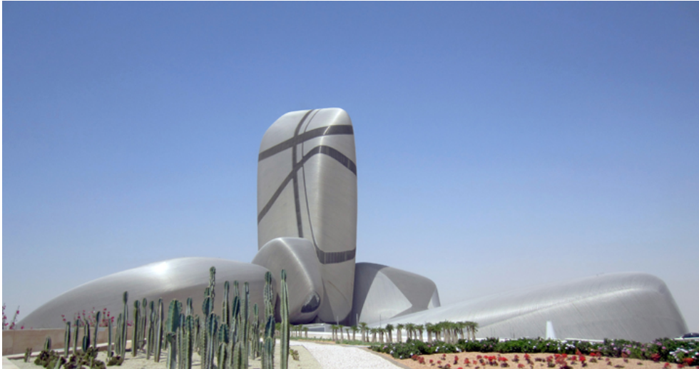
Im Herzen der saudi-arabischen Ölfelder: Das King Abdulaziz Center for World Culture mit einer 30.260qm großen Edelstahlrohrfassade ©seele/Diemo Schillack
