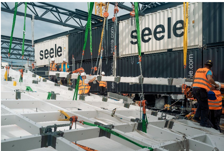
Fixierung der Stahlbausegmente mittels Kettenzügen und Schwerlastgurten über die drei Gitterträger am jeweiligen Segmentschwerpunkt. © SEELE
