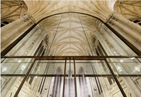
Innenfassade von St. Patricks Cathedral, New York, mit umlaufender Messingverkleidung © Stephan Wurster
